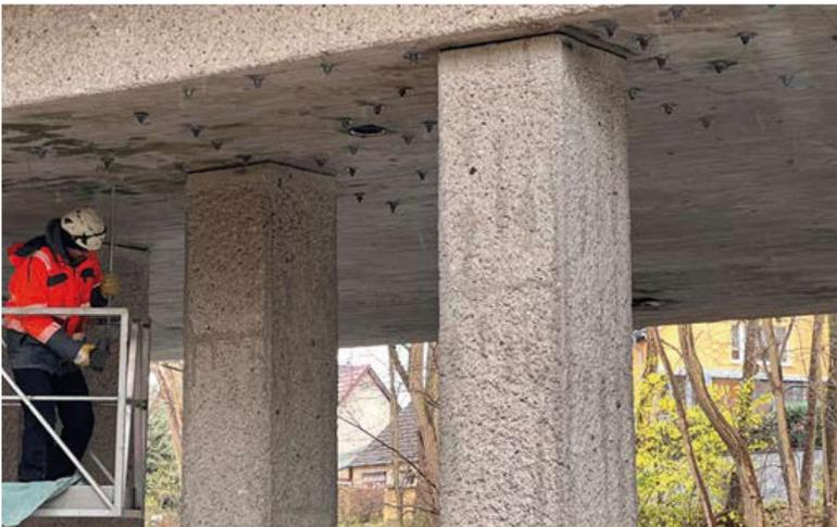
Abb.6: Verstärkung der Brücke unter laufendem Verkehr
