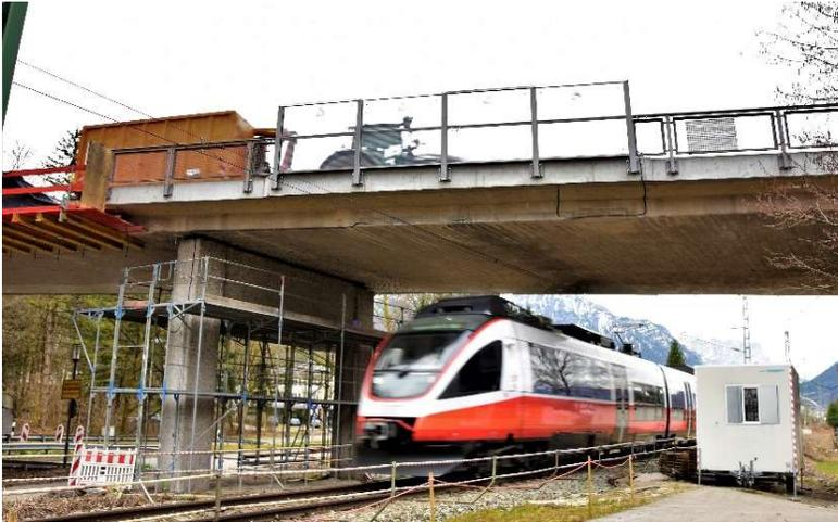
Abb.8: Querkraftverstärkung unter laufendem Verkehr
