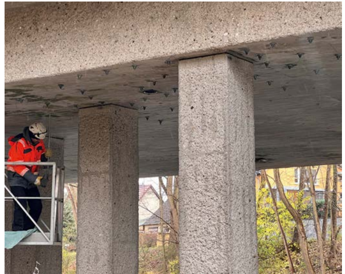
Bild 3 Verstärkung der Brücke über den Werbellinkanal unter laufendem Verkehr
