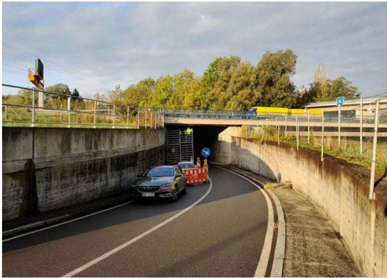
Bild 4 Sanierung der Brücke von der Unterseite unter laufendem Verkehr
