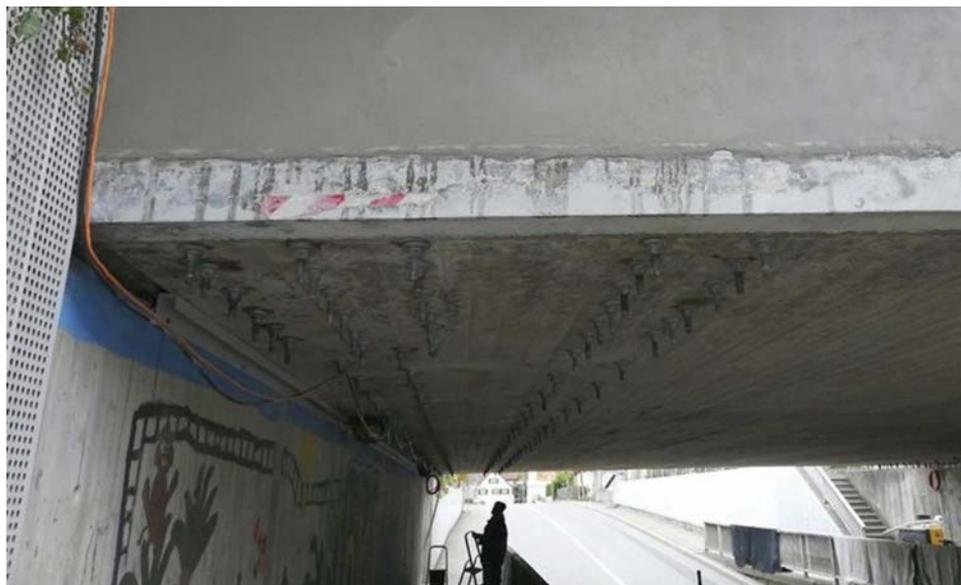
**Bild 4** Verstärkung einer Eisenbahnunterführung mit RELAST Verbundankerschrauben (Bild mit freundlicher Genehmigung der ÖBB)
