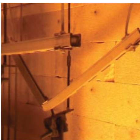
Bild 3: Abgehängtes System nach Brandbeanspruchung
