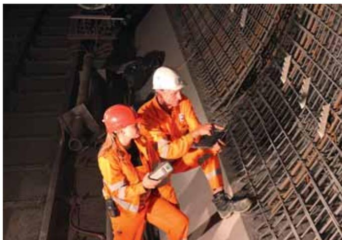
Mit modernen Geräten lässt sich das Deckungsmaß feststellen. So können mögliche Positionen für Bohrungen gefunden werden, um die Bewehrung nicht oder nur unwesentlich zu beschädigen.
