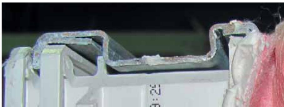
**Bild 14: Oberseitige Verstärkung des Fensterprofils mit Stahlprofil und Rohr [11]**
