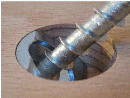
Abb. 2 und 3 Detailaufnahme Winkelscheibe 45° Hartholz mit ASSY 3.0 Teilgewindeschrauben in Baubuche
