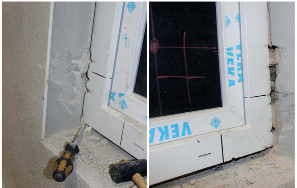
Bild 4: Beschädigungen nach mechanischem Angriff: Laibungsseite a) links mit und b) rechts ohne Armierungsputz mit Gewebeeinlage (Foto: Dr. Meyer)
