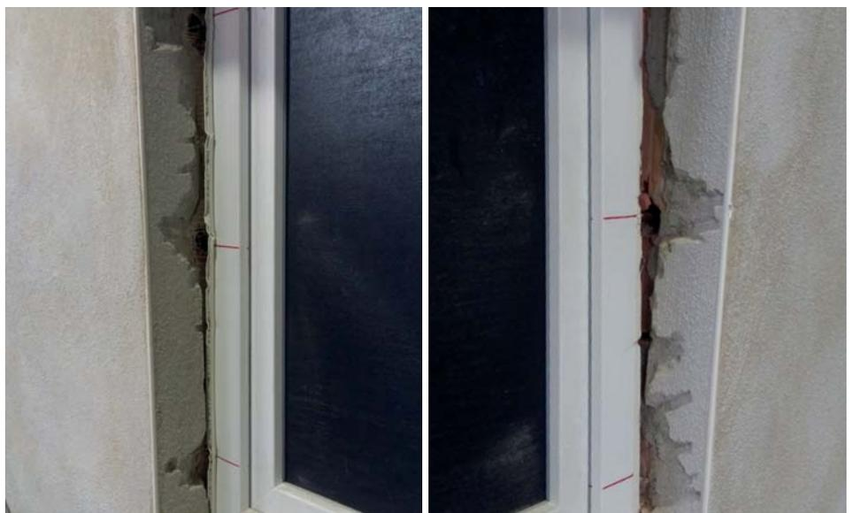
Bild 5: Beschädigungen nach mechanischem Angriff: Laibungsseite a) links mit und b) rechts ohne Armierungsputz mit Gewebeeinlage (Foto: M. Ruppik)
