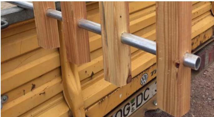
Abb. 5: Aufgefädelte Lattung auf Aluminiumrundstab
