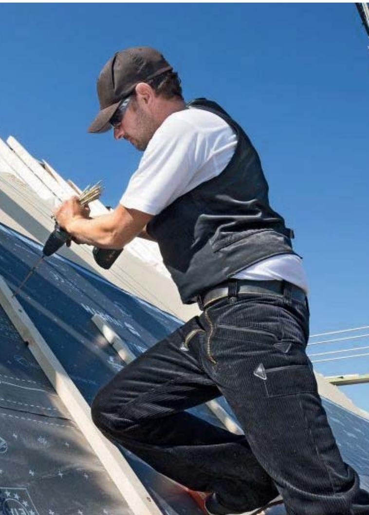
Spannweite A + B berücksichtigt. Die auf Druck beanspruchten Schrauben bilden die Auflager des Durchlaufträgers und über die auf Zug beanspruchten Schrauben werden konzentrierte Einzellasten rechtwinklig zur Lattenlängsrichtung eingetragen.
