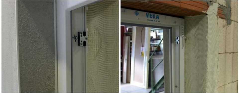
Bild 3: Eingeputztes Fenster vor dem Versuch: a) Außenseite b) Innenseite der von außen gesehenen linken Laibungsseite mit Armierungsputz mit Gewebeeinlage (Foto: Dr. Meyer)
