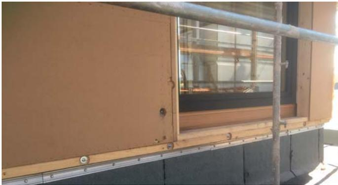
Abb. 3: Holzrahmenkonstruktion mit Holzfaserdämmplattenoberfläche
