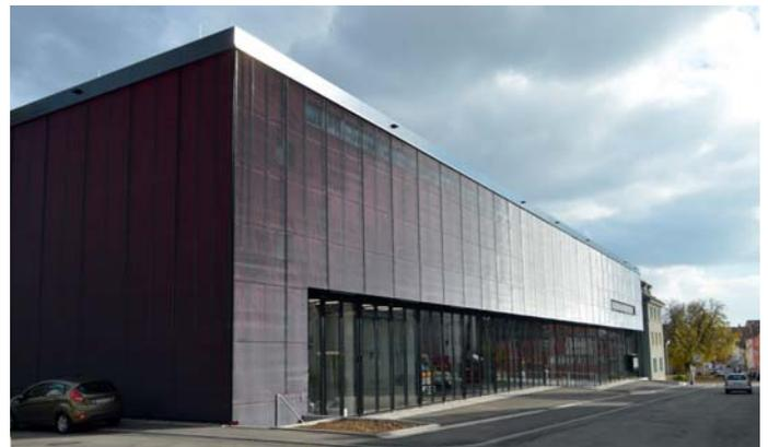
Souverän mit Metall: Die Fassadenmembranen von Stamisol bieten gerade bei offenen Metallgeweben oder Steckmetall einen optimalen thermischen Schutz.
