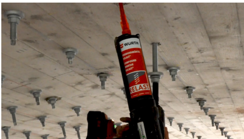
Eingebaute Querkraftverstärkung mit Verbundankerschraubensystem RELAST® von Würth
