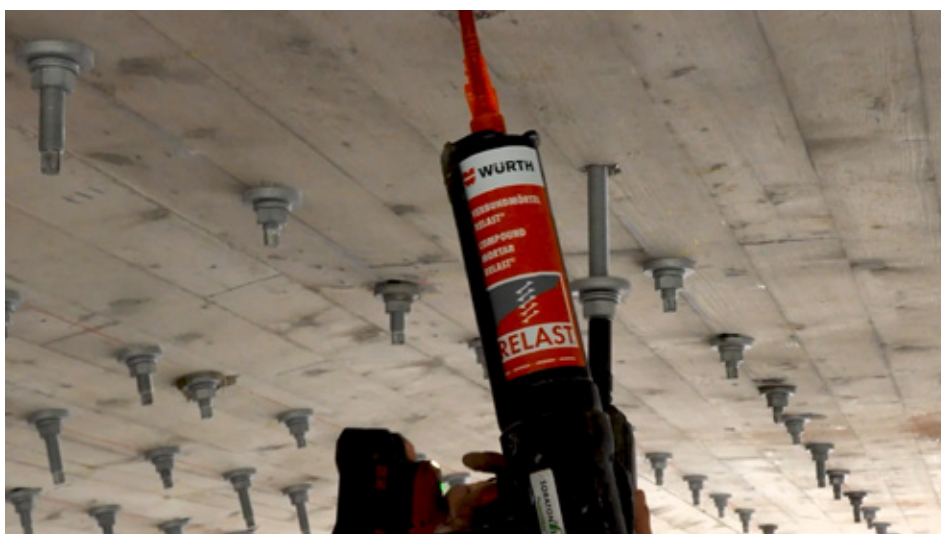
Eingebaute Querkraftverstärkung mit Verbundankerschraubensystem RELAST® von Würth
