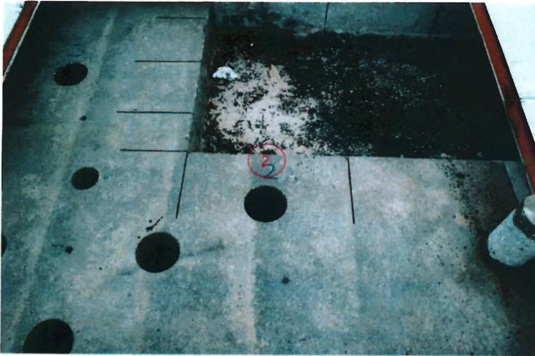
Bild 3: Entnahmebereich – Bohrkernprobe 2
