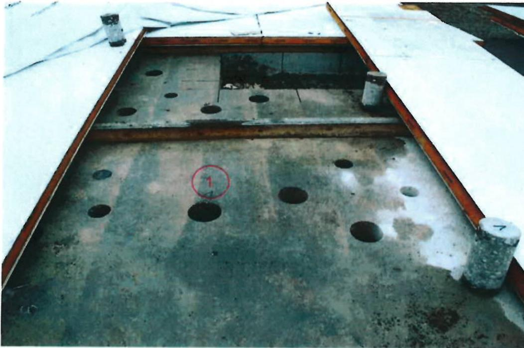
Bild 1: Entnahmebereich – Bohrkernprobe 1
