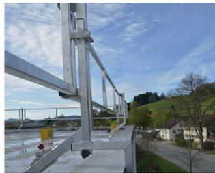
Die Attika-Abbrutschsicherung muss bei aufkommendem Wind oder nach Arbeitsende angebaut werden, um das Geländer zusätzlich gegen Wind zu sichern.
