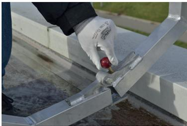
Abklappbare Geländerpfosten erlauben Arbeiten auch im Bereich der Ausleger.
