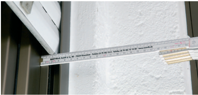
Abstand Rollladenführung zum Blendrahmen ermitteln.
