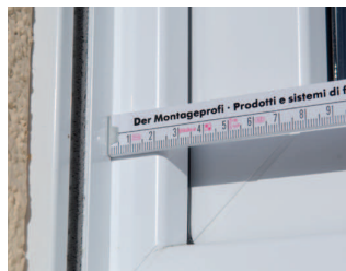
Obere, untere und seitliche Blendrahmenüberstandsfläche ermitteln.
