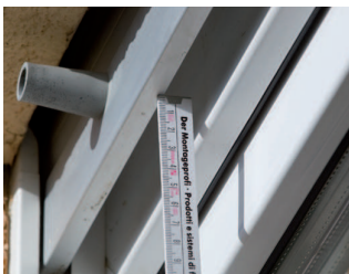
Obere, untere und seitliche Blendrahmenüberstandsfläche ermitteln.
