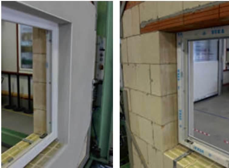
Bild 25. Eingeputztes Fenster vor dem Versuch; a) Außenseite, b) Innenseite der von außen gesehenen rechten Laibungsseite (Fotos: Dr. Meyer)
