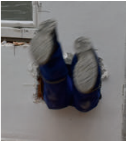
Bild 7. „Durchgangsfähige Öffnung“ (Foto: Küenzlen)
