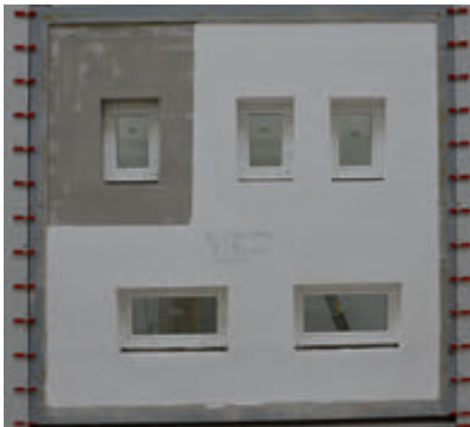
Bild 29. Forschungsprojekt „Einbruchhemmung mit hochwärmedämmendem Ziegelmauerwerk“: verschiedene Fenstergrößen, Fensterformate und Putzaufbauten in den Klasse RC 2 und RC 3 (Foto: Küenzlen)
