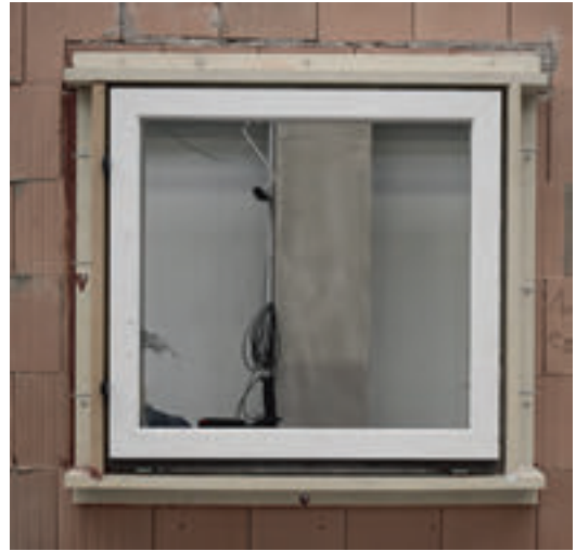
Bild 53. Als einbruchhemmend in der Klasse RC 2 zertifiziertes Fenster montiert an einem – an einer Wand aus Hochlochziegeln – verklebten Winkel aus PUR-Composit-Material (Foto: Künzlen)
