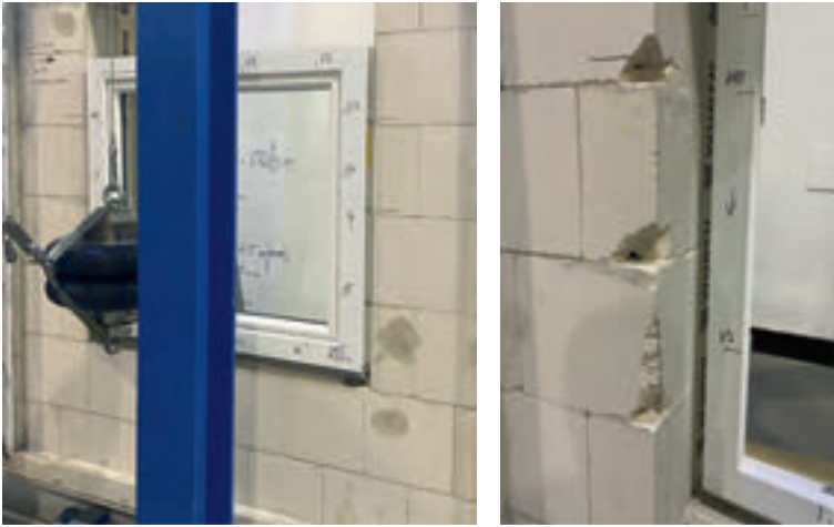
Bild 33. Ausbruch der Abstandsmontageschrauben aus einem Kalksandlochstein bei einem dynamischen Versuch nach DIN EN 1629 in der Klasse RC 2 (Fotos: Grammling)
