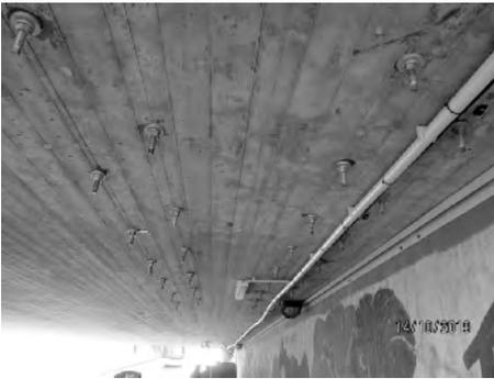
**Bild 44.** Von unten in die Platte eingebaute Querkraftverstärkung der Eisenbahnunterführung (mit freundlicher Genehmigung der österreichischen Bundesbahnen)
