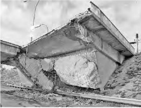
**Bild 5.** Einsturz des De la Concorde Overpass in Quebec im Jahr 2006 (aus [34])
