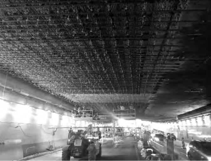
**Bild 54.** Einbau der Querkraftverstärkung von unten und Einbau der nachträglichen Biegezugbewehrung an der Nordseite des Tunnels unter Aufrechterhaltung des Verkehrs (Prof. Feix Ingenieure GmbH)
