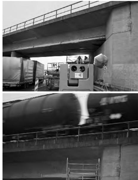
**Bild 50.** Aufrechterhaltung des Verkehrs auf und unter der Brücke während des Einbaus der Verstärkungselemente (mit freundlicher Genehmigung der Toge Dübel GmbH & Co. KG)
