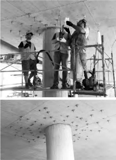
**Bild 48.** Einbau der Durchstanzverstärkung von unten um die Rundstützen unter laufendem Betrieb auf und unter dem Tragwerk (mit freundlicher Genehmigung der Asfinag)
