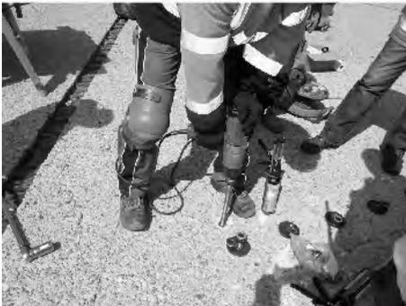
**Bild 46.** Injizieren des Verbundmörtels in die gebohrten Löcher und Eindrehen der Verstärkungselemente mittels Tangentialschlagschrauber (mit freundlicher Genehmigung der Baudirektion des Landes Burgenland)
