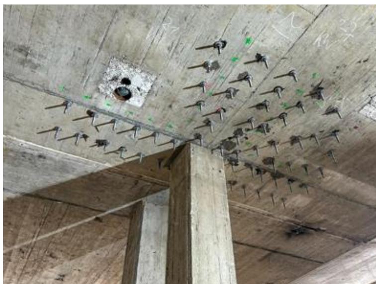
Anordnung der Verstärkungselemente rund um die Stütze
