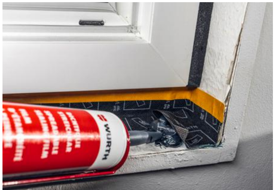
Häufiger Fehler: Unzureichende Abdichtung des Fensterrahmens kann Wärmeverluste und Feuchtigkeitsschäden verursachen.
