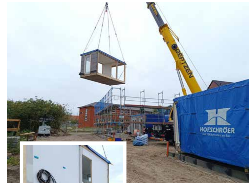
Präzise Positionierung des Moduls per Kran – ein Vorteil des Modulbaus.
