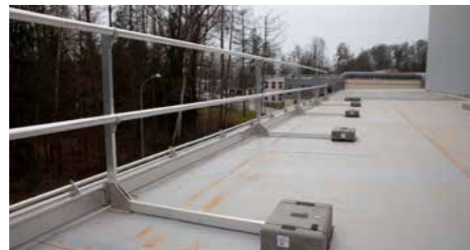
Abbildung 2: temporäres Seitenschutzsystem nach DIN EN 13374
