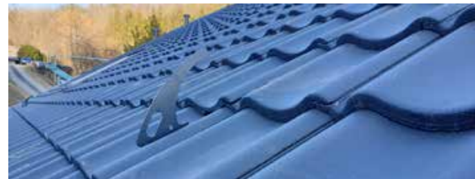
Abbildung 4: Sicherheitsdachhaken nach DIN EN 517
