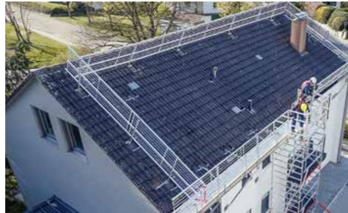
Abbildung 3: Temporäres Steildach-Seitenschutzsystem und fahrbare Arbeitsbühne mit Dachzugangsset
