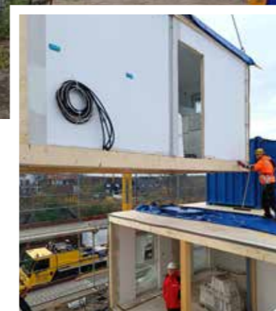
Präzise Positionierung des Moduls per Kran – ein Vorteil des Modulbaus.
