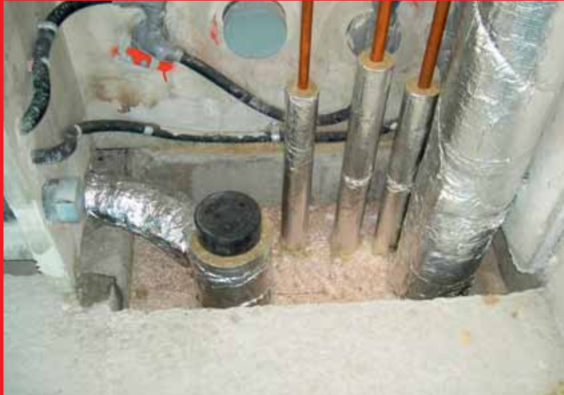
Deckendurchführung mit IBS 90 Trockenschüttung.
