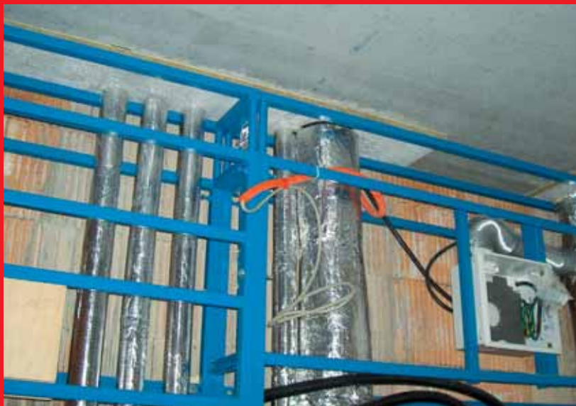
IBS 90 in Verbindung mit einem Installationsschachtsystem.
