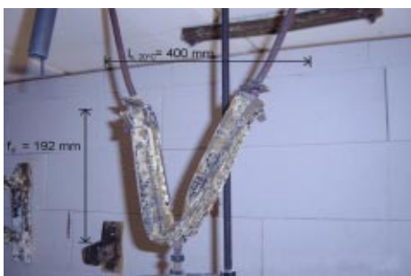
Bild 9: Schienensystem nach Brandbeanspruchung.
